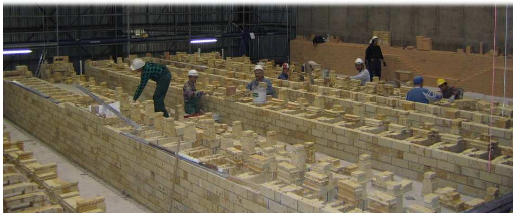
FIGURE 2.2 – Géométrie des briques et arrangement architectural d'un piédroit lors de sa construction.
