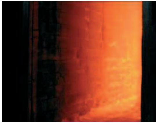
FIGURE 1.19 – Exemple de panneresse endommagée d'après [Nivoix, 2008].
