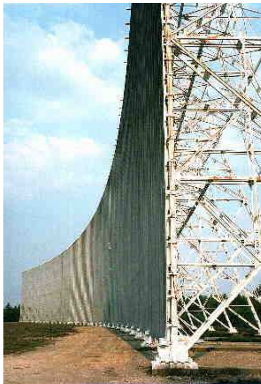
Figure III.3 : miroir fixe : portion de sphère de 560 m de rayon
