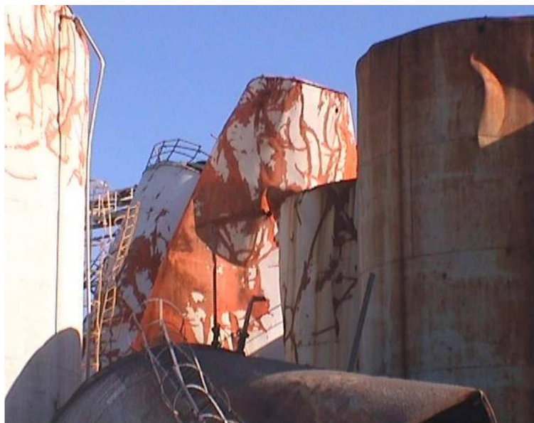
FIGURE 2.2 – Flexion de deux réservoirs élancés (AZF 2001).
