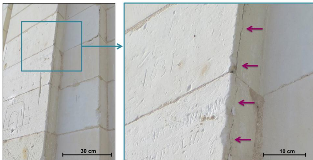
FIGURE 52 : EXEMPLE DE FISSURES SUR LE COTE D'UN PILASTRE
