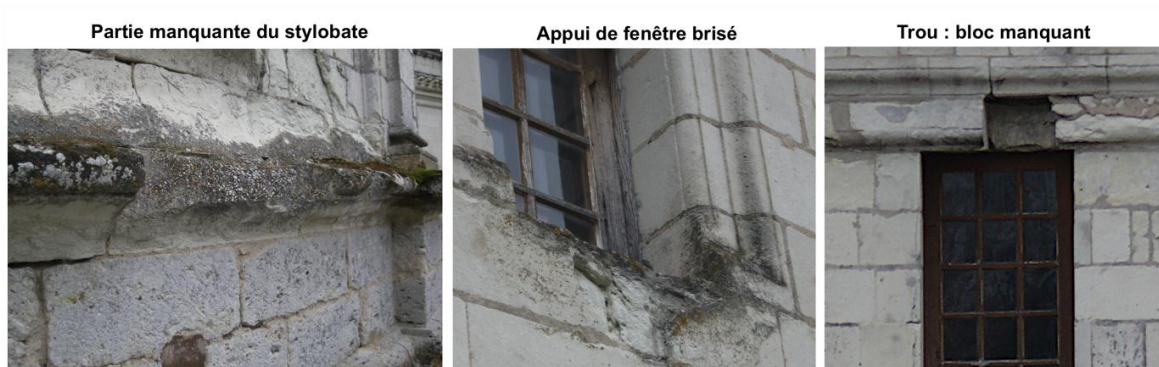
FIGURE 51 : EXEMPLES DE PARTIES MANQUANTES ET CASSURES
