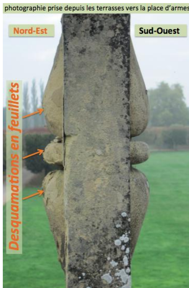
FIGURE 57 : ORIENTATION LA PLUS FREQUENTE DES DESQUAMATIONS EN FEUILLETS SUR LES BALUSTRES DE L'AILE SUD
