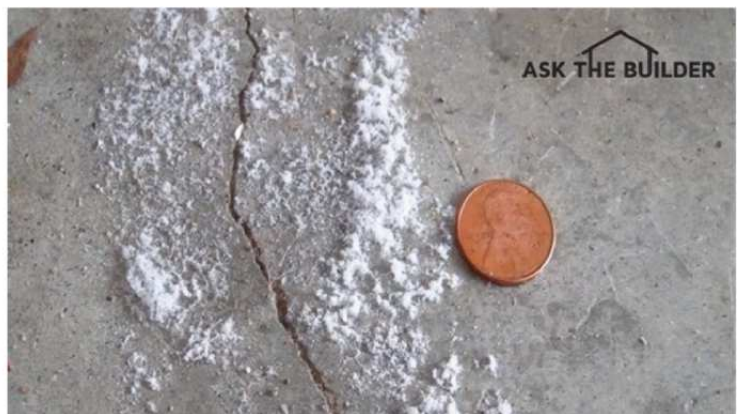
Fracturation et efflorescence associées sur un béton
