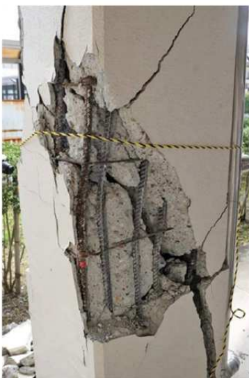
Pilier en béton désintégré designarchitecturart.com
