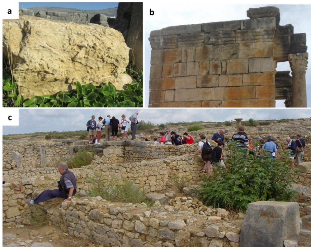
Figure I-17 a) Alvéolisation d'une calcarénite b) Patines d'oxalates et colorations noires en haut de l'Arc de Triomphe c) Erosion touristique (Fentress et al. 2004)
