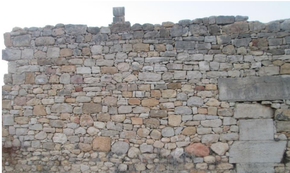
Figure I-12 Exemple d'un mur à Volubilis composé de différentes pierres
