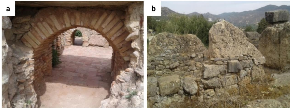
Figure I-10 a) Voûte en brique cuite b) Elévation en brique crue
