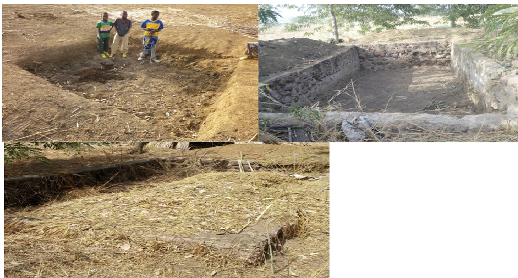
Figure 19 : Creusage, stabilisation et remplissage de la fosse à compost (Sampieri 2014, Auteur Coulibaly Aboubacar)
