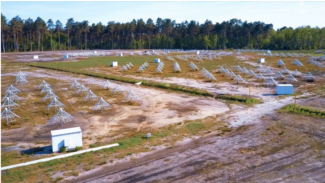
FIGURE 7.1 – Photographie aérienne de NenuFAR. On y aperçoit distinctement les mini-réseaux de 19 antennes ainsi que les boîtiers de phasage analogiques correspondants. L'image provient de https://www.obs-nancay.fr/-NenuFAR-45-.html .
