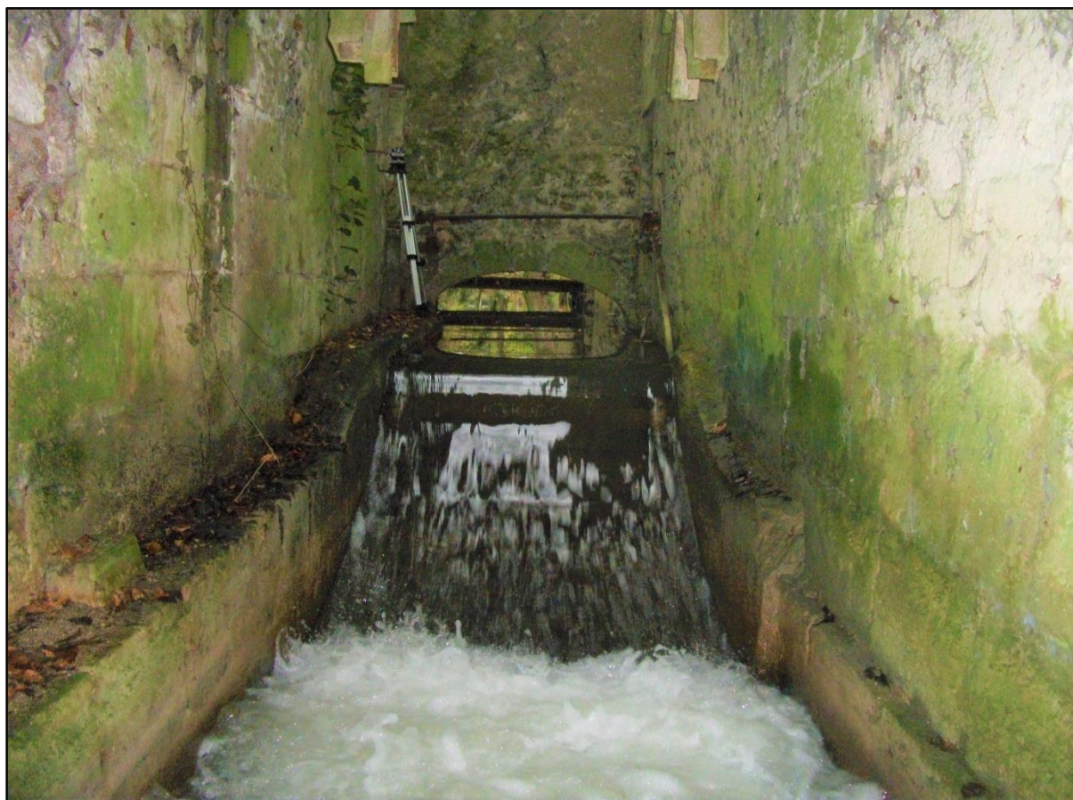
Figure 31 : Le seuil en rivière qui forme la retenue de seuil de Saint-Hilaire à Meung sur Loire (Source : Comm.de Comm. Terres du Val de Loire).
