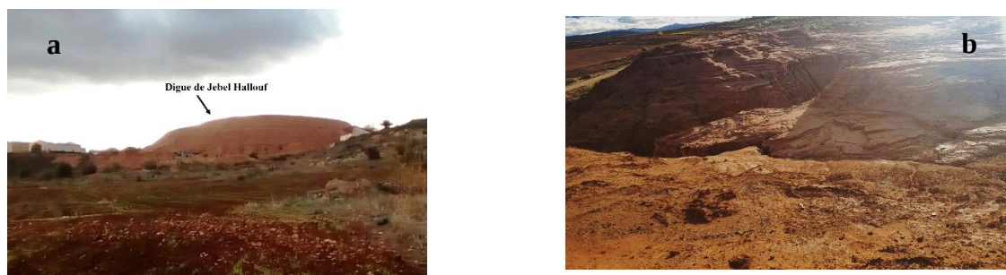
Figure II. 8 : Photos de la digue a stérile de Jebel Hallouf (a) et Sidi Bouaouane (b)
