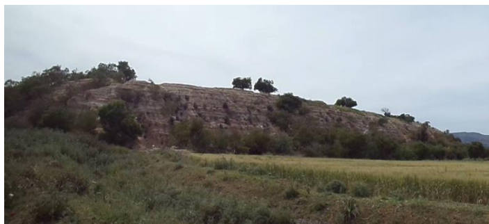
Figure II. 10 : Photo de la digue de Jalta
