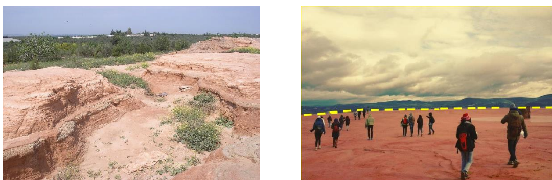
Figure II. 6 : Photos de la Digue de Jebel Ressas
