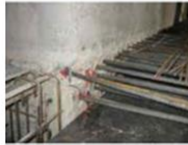
(b) Connexion mur-plancher
