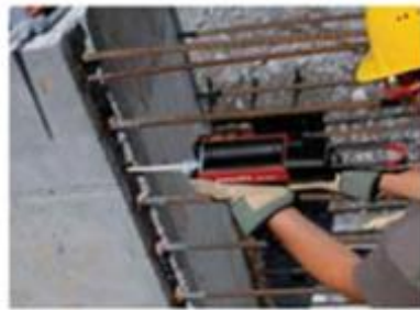
(a) Extension d'un mur
