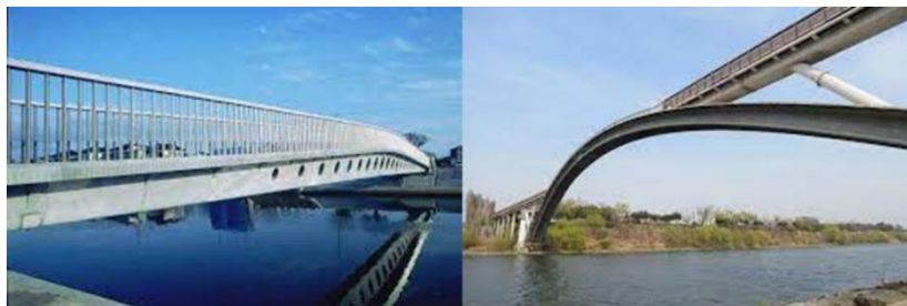
Figure 1.1 : La passerelle piétonne de Sakata-Miraï.
