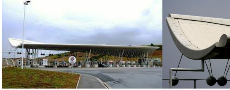
Figure 1.2 : Toiture de la gare de péage du viaduc de Millau.
