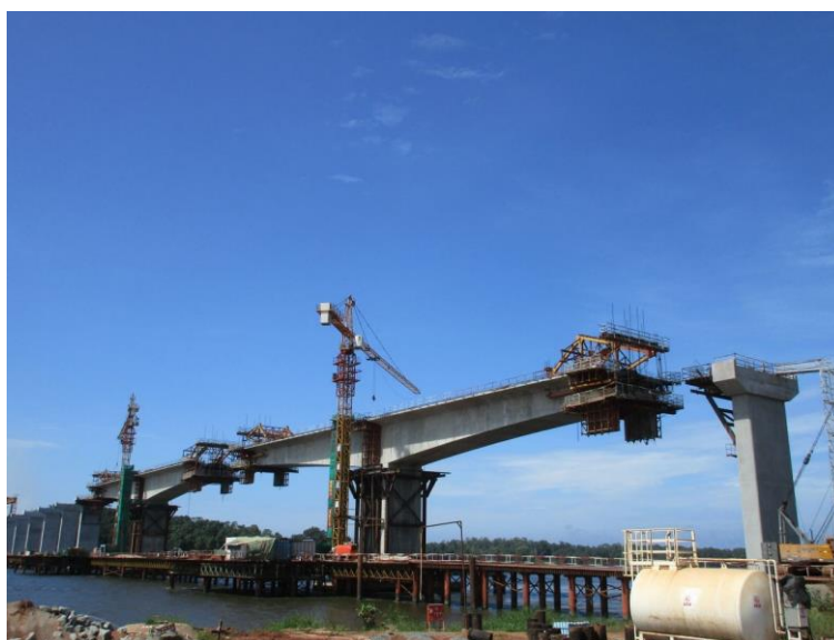
Planche 14: Travaux des ponts Ozouri et Komie (Cliché : Moumbongoyo, CEDETE, 2022)
