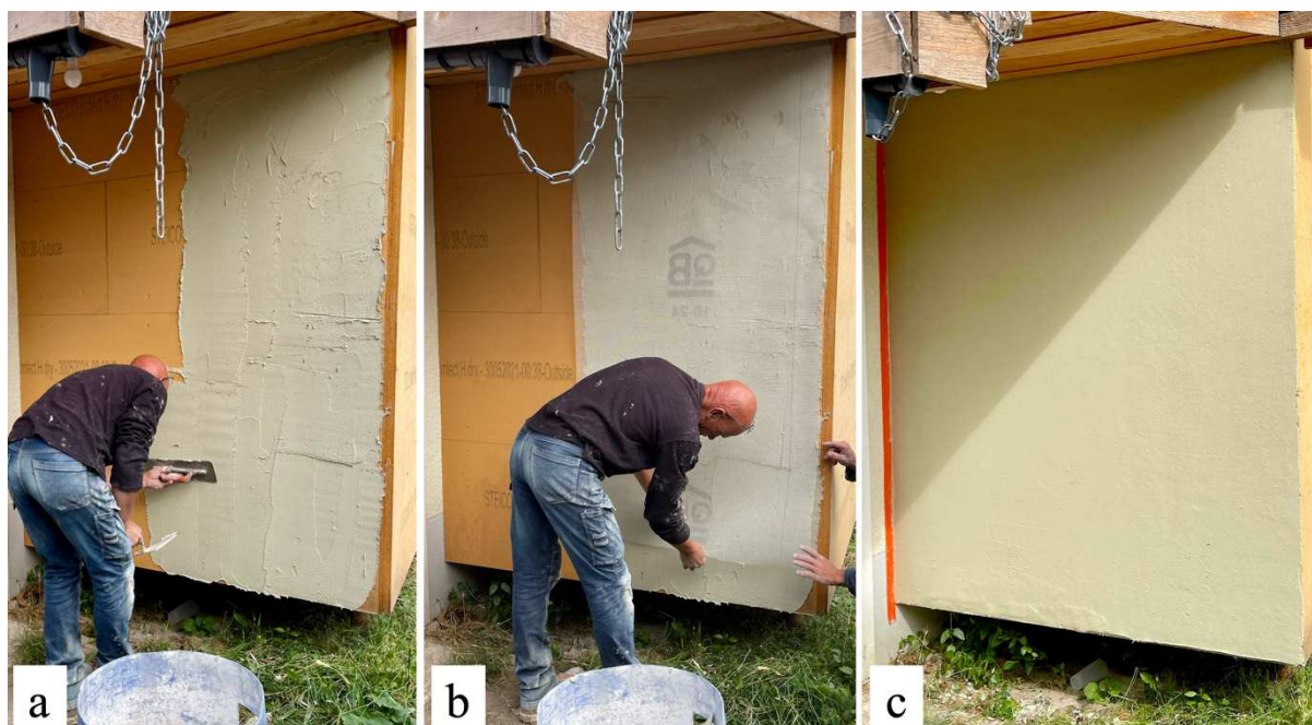
Figure 122 : Les étapes de l'application de l'enduit à l'état frais : (a) application de la première couche d'enduit ; (b) installation de la grille de renfort ; (c) application de la deuxième couche de l'enduit
