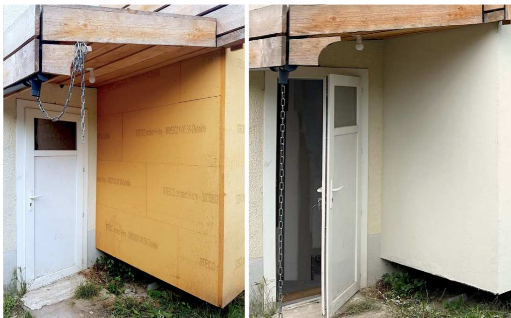
Figure 121 : Le mur Sud avant et après l'application de l'enduit
