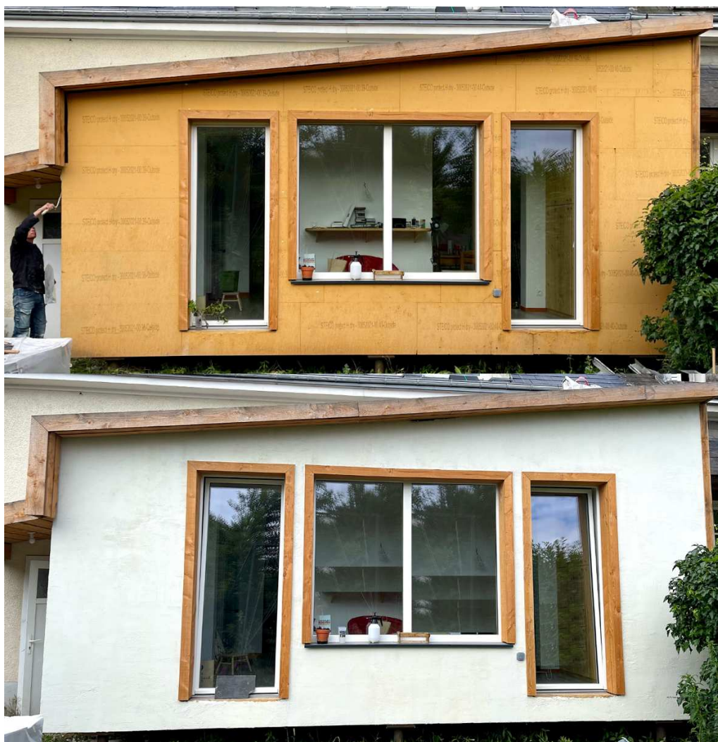
Figure 120 : Le mur Est avant et après l'application de l'enduit
