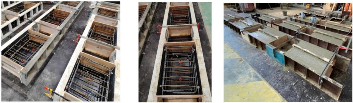
Figure 29: Coffrage et disposition des armatures transversales avant la coulée
