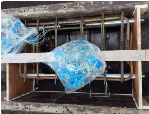
Figure 30 : dalle instrumentée par des échelles de thermocouples pour l'essai de chauffage électrique
