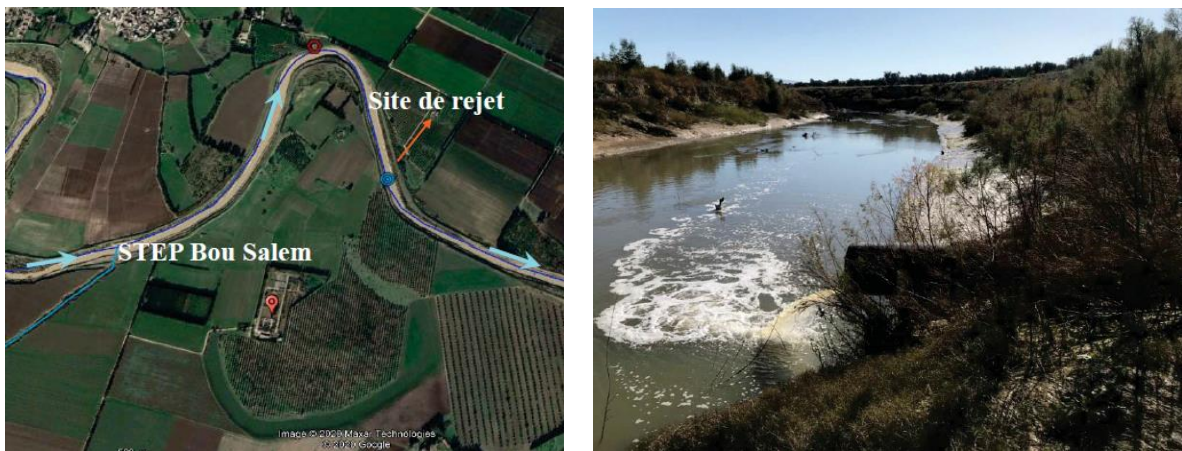
Figure 4. 1: Rejet des eaux usées traitées de la STEP de Boussalem
