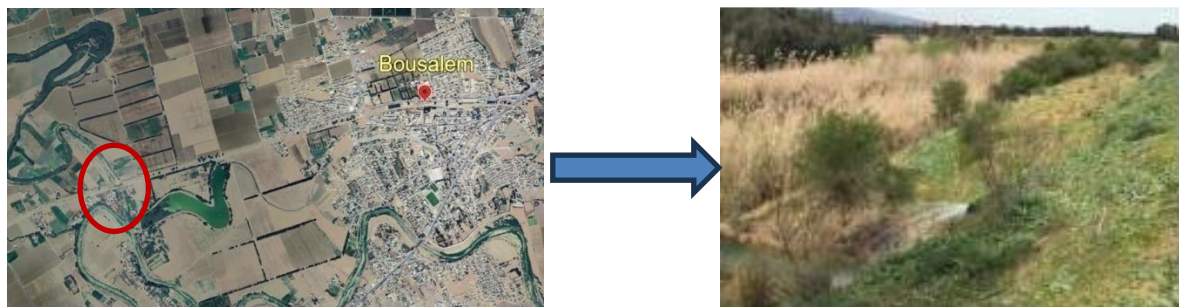
Figure 2. 15 : Points de rejets hydriques agricoles observés à l'amont de Boussalem
