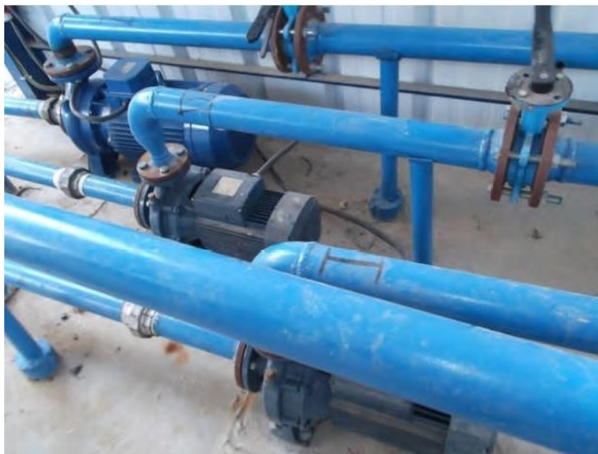
Figure 5. 3 : Le groupe des électropompes
